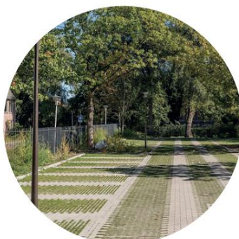
Parkeren op grasbetontegels
