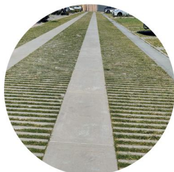
Karrespoor met grasbetontegels
